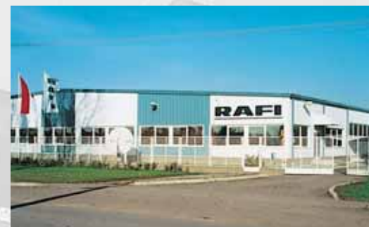
Assembly plant in Hungary (Mezőtúr)
